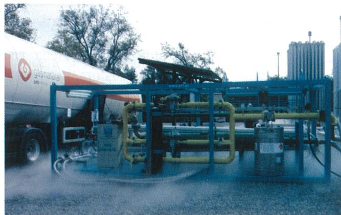
**Equipamento de aquecimento e controlo** - Este equipamento é constituído por um contentor onde estão incluídos os componentes necessários ao controlo de todo o processo e à produção de água quente para a vaporização do GNL.
