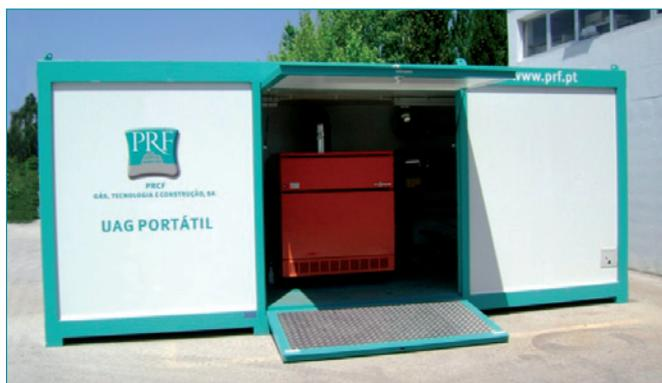
Além de funcionar de forma autónoma, a **UAG PORTÁTIL** permite ainda uma monitorização remota através de um sistema de comunicações.
