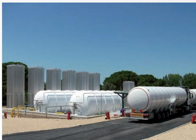
Trata-se de uma UAG com uma capacidade de armazenagem de 400 m<sup>3</sup> (dois reservatórios de 200 m<sup>3</sup>). Foram duplicados os equipamentos de descarga de cisternas, para permitir descargas simultâneas.
